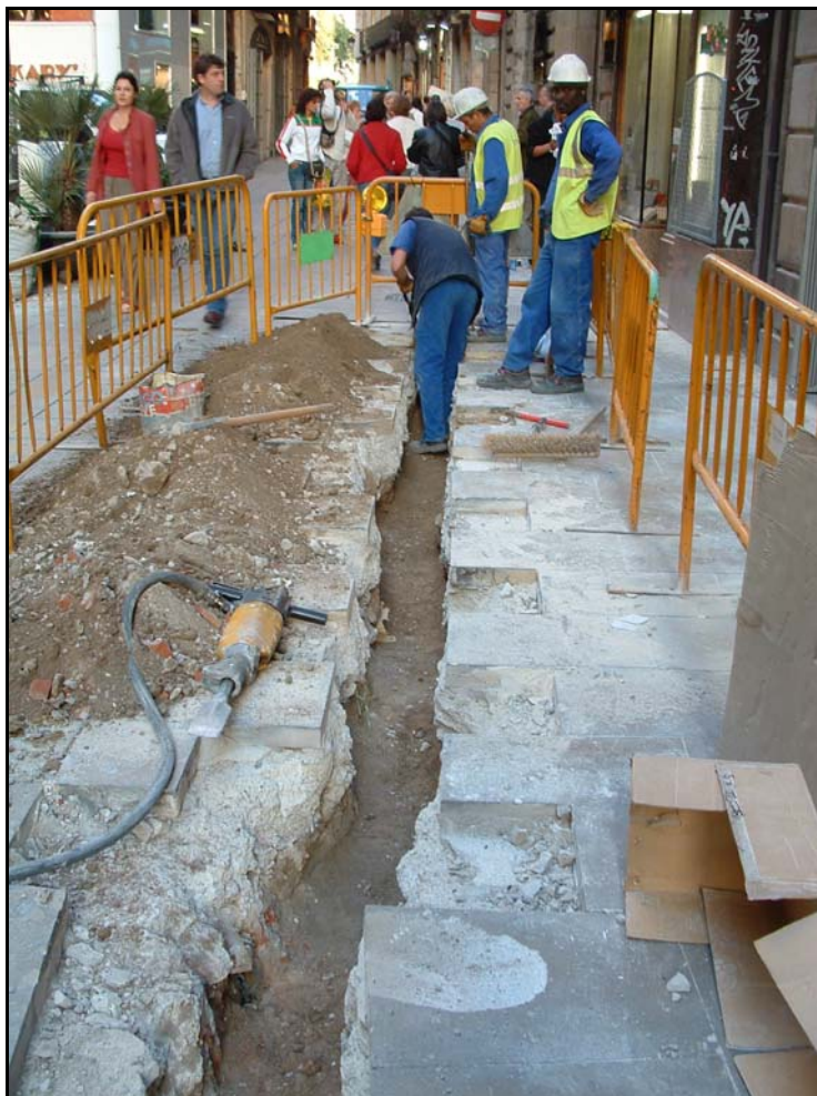
Fotografia 7. Detall rasa realitzada al carrer Portaferrissa, un cop realitzat el buidatge de terres. En direcció Plaça Nova.
