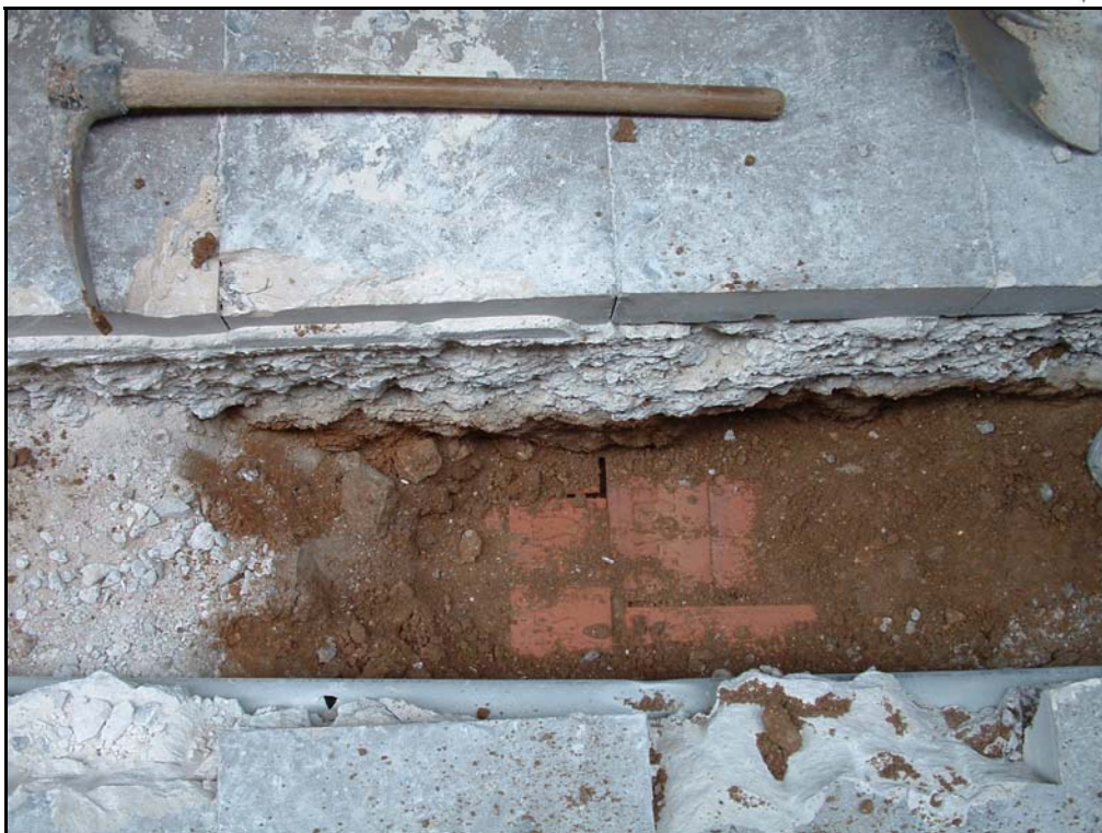
Fotografia 3. Detall tram de la rasa realitzada al carrer del Pi, durant el buidatge de terres on es pot apreciar el servei de la llum localitzat per sota el nivell de rebliment U.E. 04.
