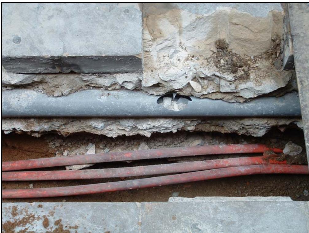
Fotografia 4. Detall perfil tram rasa carrer del Pi, sobre el número 10, on s'aprecien els serveis localitzats durant els treballs.
