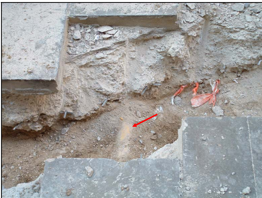
Fotografia 9. Detall servei del gas localitzat a la rasa R/2 realitzada al carrer Portaferrissa, 2.
