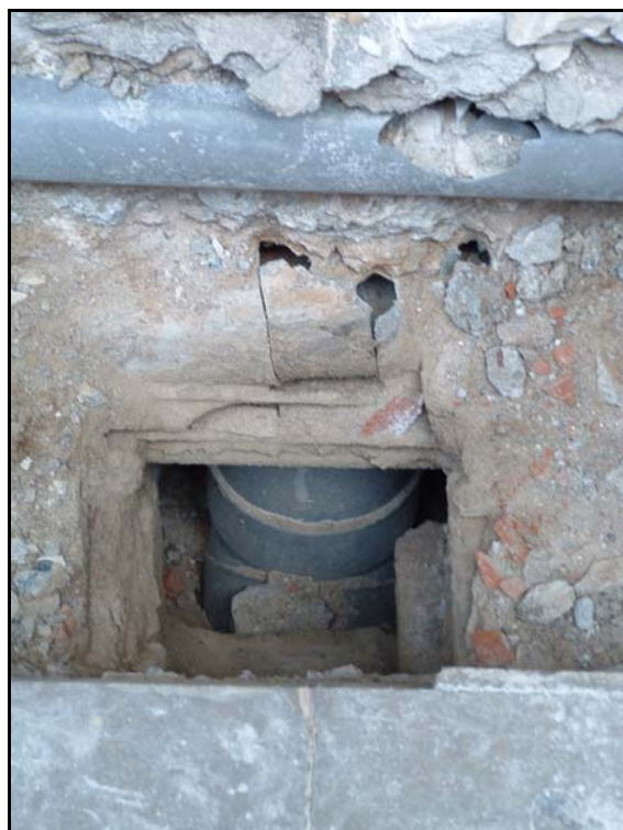
Fotografia 6. Detall claveguera contemporània localitzada durant els treballs al carrer del Pi.
